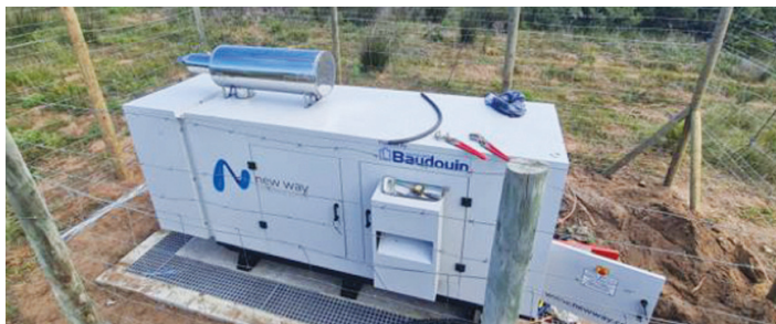
Die kragopwekker wat by die Stanford-produksieboorgat geïnstalleer is
